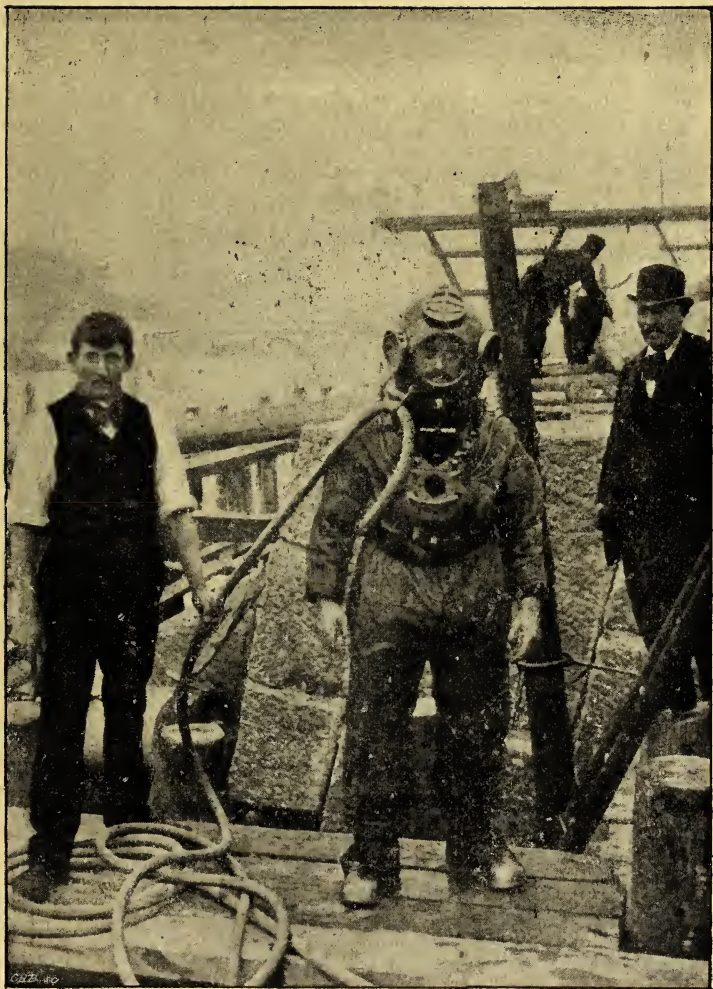
FONT ALEXANDRE III. — UN SCAPHANDRIER DESCENDANT DANS LA SEINE POUR LE DÉRIVAGE DES HAUSSES D'UN CAISSON DU PONT (30 juin 1898).
